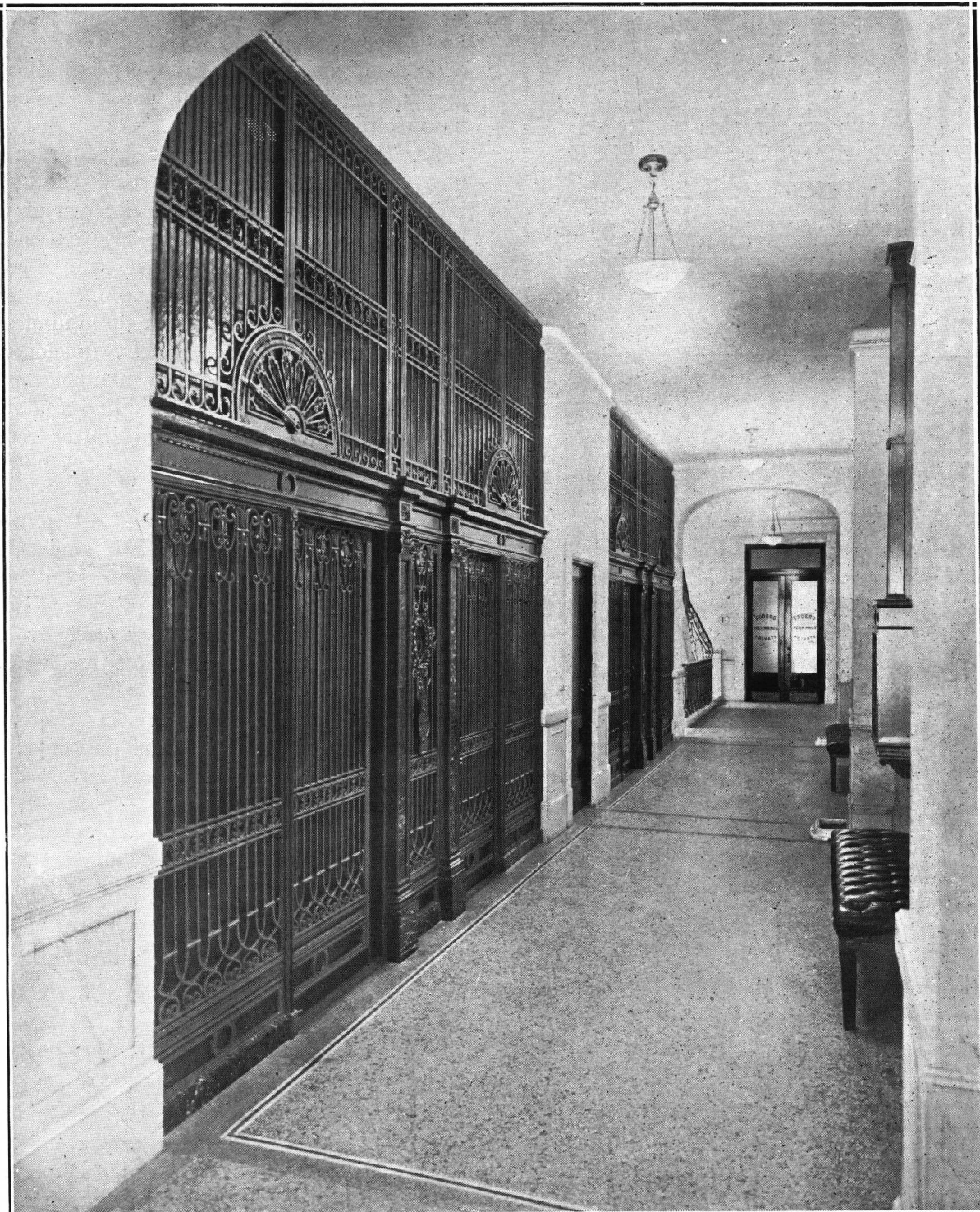
CUATRO ASCENSORES OTIS
