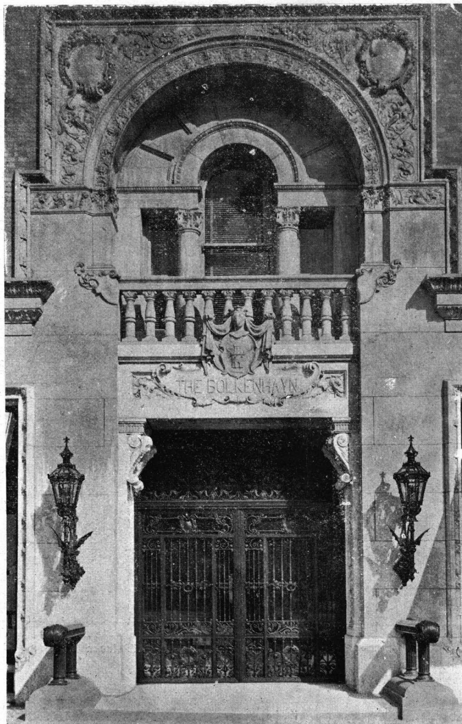
« The Bolkenhayn ». Detalle de la fachada
