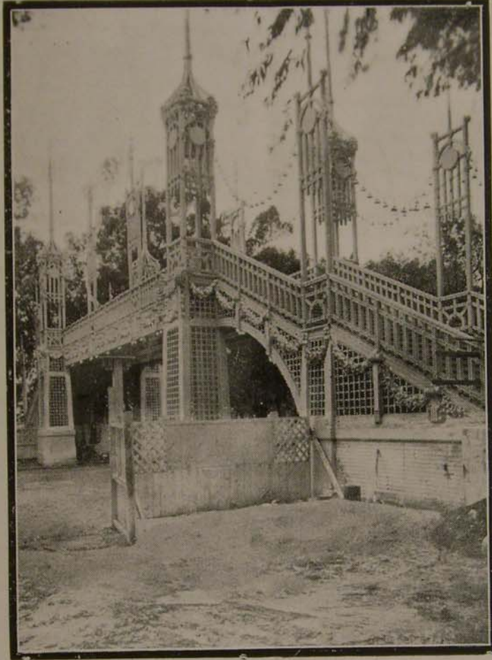
DETALLE DEL PUENTE SOBRE LA AVENIDA PRESIDENTE MONTT
