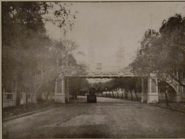
PUENTE SOBRE LA AVENIDA PRESIDENTE MONTT
