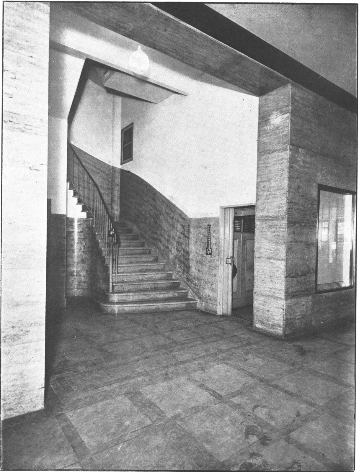
Vestíbulo de la escalera
