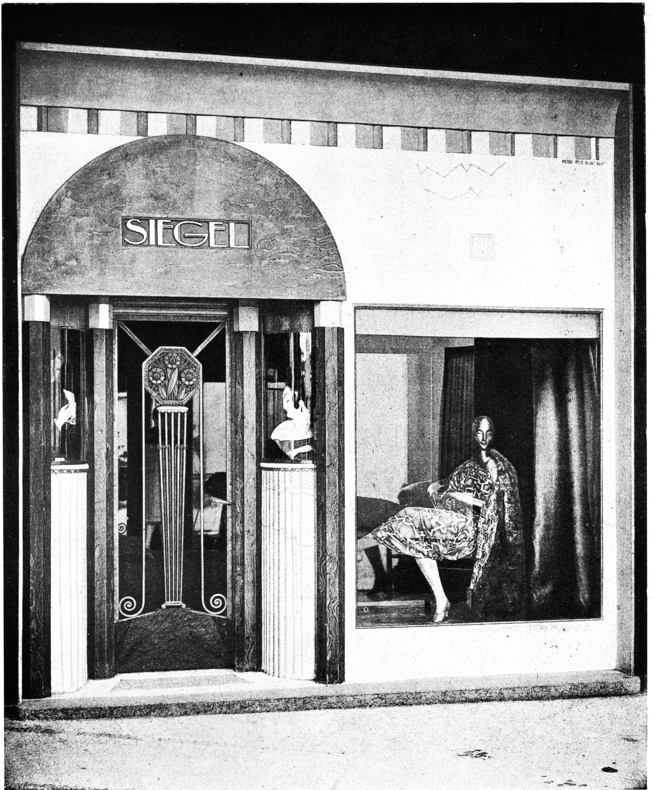
FACHADA DE "MAGASINS"
