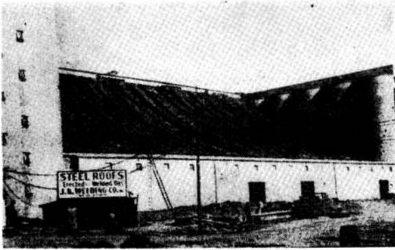
Iniciación de una era en la construcción moderna de estructuras colgantes: el almacén de granos en Albany, con cubierta de membrana de pa-lastro suspendida.
