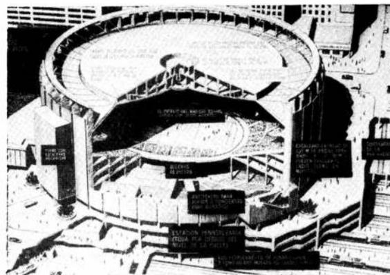
Una estructura colosal: dentro de la cubierta suspendida de 129 metros de diámetro del nuevo edificio del Madison Square Garden se aloja una torre de refrigeración y equipos de iluminación en dos niveles, de acero.
