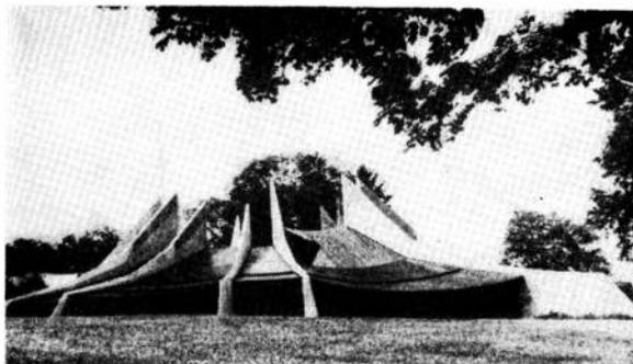
Sugestivos tabiques de hormigón que apuntan simbólicamente hacia el cielo, sostienen la red de cables de la cubierta de tracción de esta ascética iglesia de Nueva Inglaterra.
