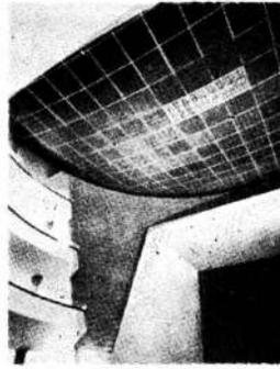
Cuando el Teatro Coliseo debió remodelarse, el cielo-raso ejecutado con una estructura de tracción, resolvió un problema acústico.
