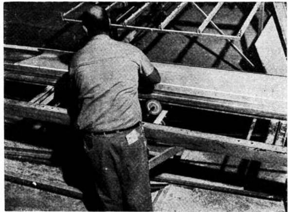
La tabla de yeso, que ya viene cortada, se coloca sobre el panel de hierro que tiene colocado el adhesivo; no hay perforaciones.
