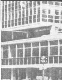
Chapas traslúcidas de poliéster reforzado y elementos moldeados con fibra de vidrio.
