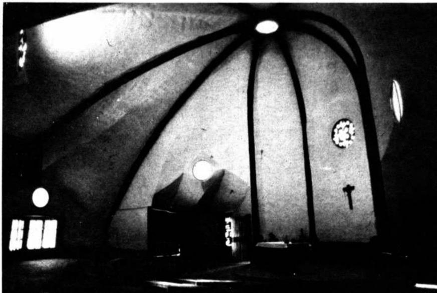
Capilla Maria Madre de la Iglesia, Barrio Trujui, Moreno, Pcia. de Buenos Aires. Año 1980. Fotos exteriores e interiores. El sistema constructivo utilizado es a base de metal desplegado y mortero de cemento (estructuras que trabajan por forma) y que se arma sobre malla de acero entre costillas generalmente realizadas con vigas reticuladas de acero o arcos de ladrillo.
