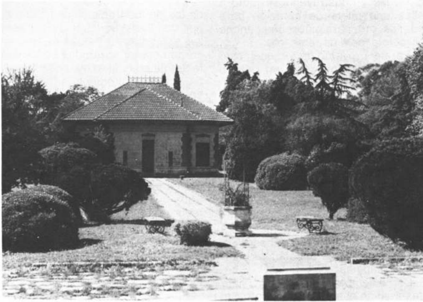
Vista del edificio destinado a vestuarios y sanitarios.
