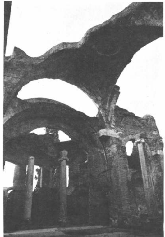
El impresionante estado actual de la gran bóveda de arista del frigidario de las Grandes Termas.
