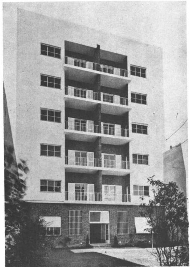
Edificio de departamentos, arq. Alberto Prebisch. (Nuestra Arquitectura, 1939)
