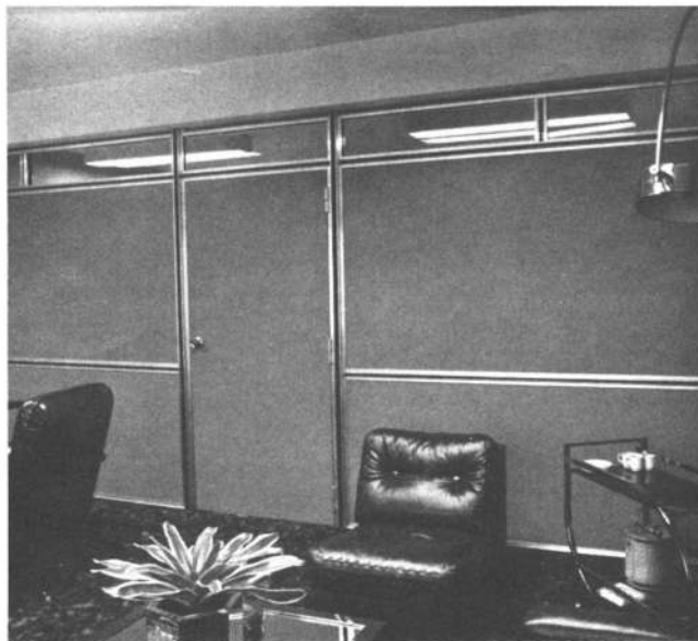
Los paneles divisores admiten diversas variantes en su colocación. Aquí ésta se ha hecho en sentido horizontal y no vertical. (Marina, Decoraciones de empresas)
