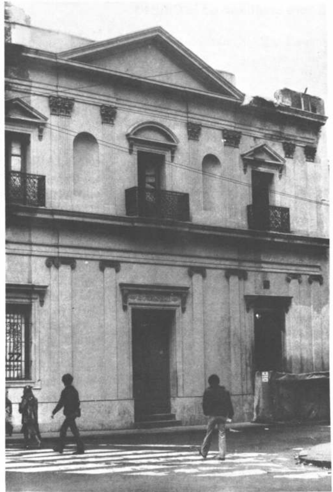
Se aprecia aquí el frontis reconstruido y el desmonte del muro que había tapado el lugar donde van situados los balaustres
