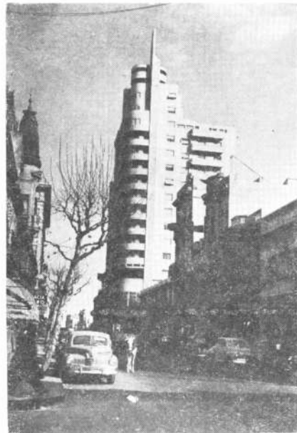
Arq. Juan A. Aubriot y Ricardo Valabrega: Edificio Lapido (1933), Avda. 18 de Julio esq. Río Branco, Montevideo.
