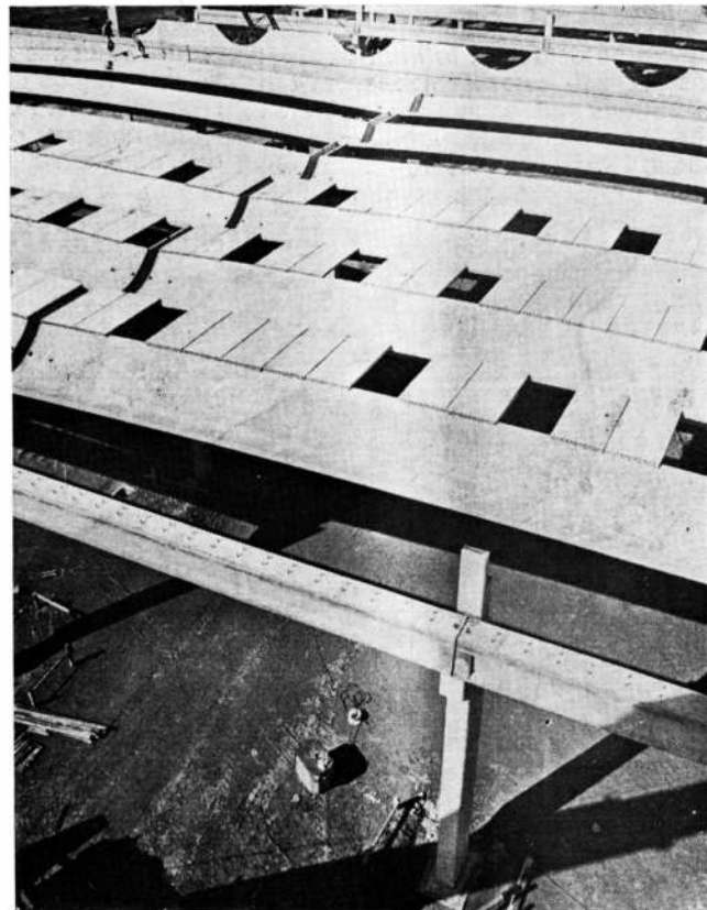
Cubierta. Bóvedas SCS, paneles pretensados. espacios para lucernas y extractores.
