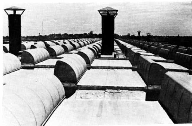
Cubierta. Bóvedas SCS, paneles pretensados, lucernas de iluminación cenital y chimeneas.
