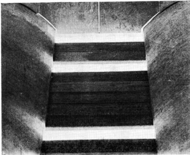
Detalle interior de cubierta. Tímpanos transversales, bóvedas SCS y paneles pretensados.
