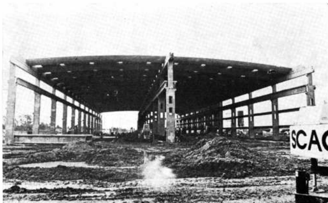
Estructura. Columnas alivianadas y vigas pretensadas.
