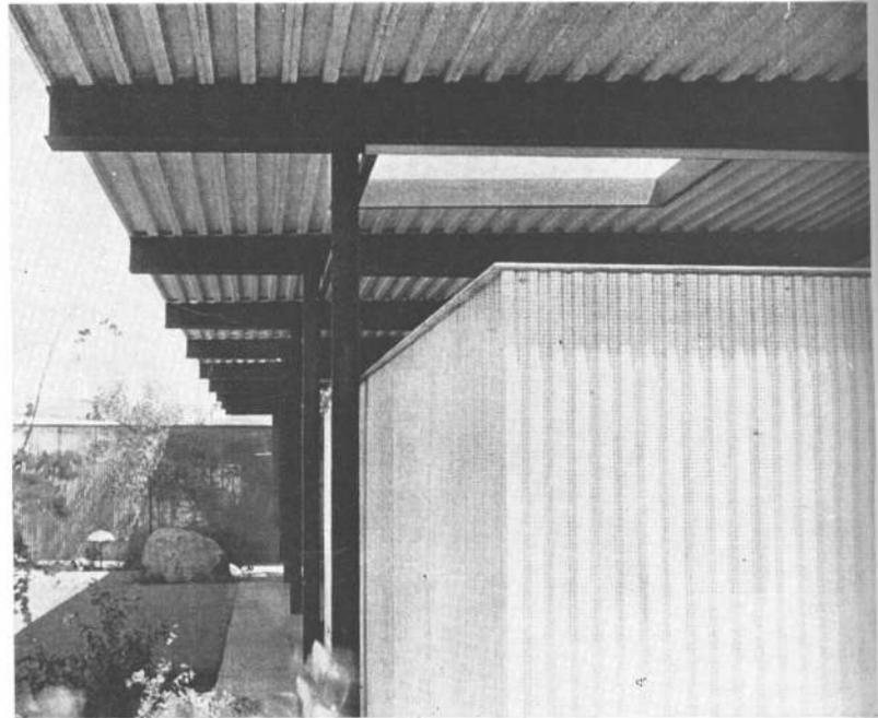
5. Las vigas se montaron sobre pilotes en tierra y se levantó el almacén entero.
