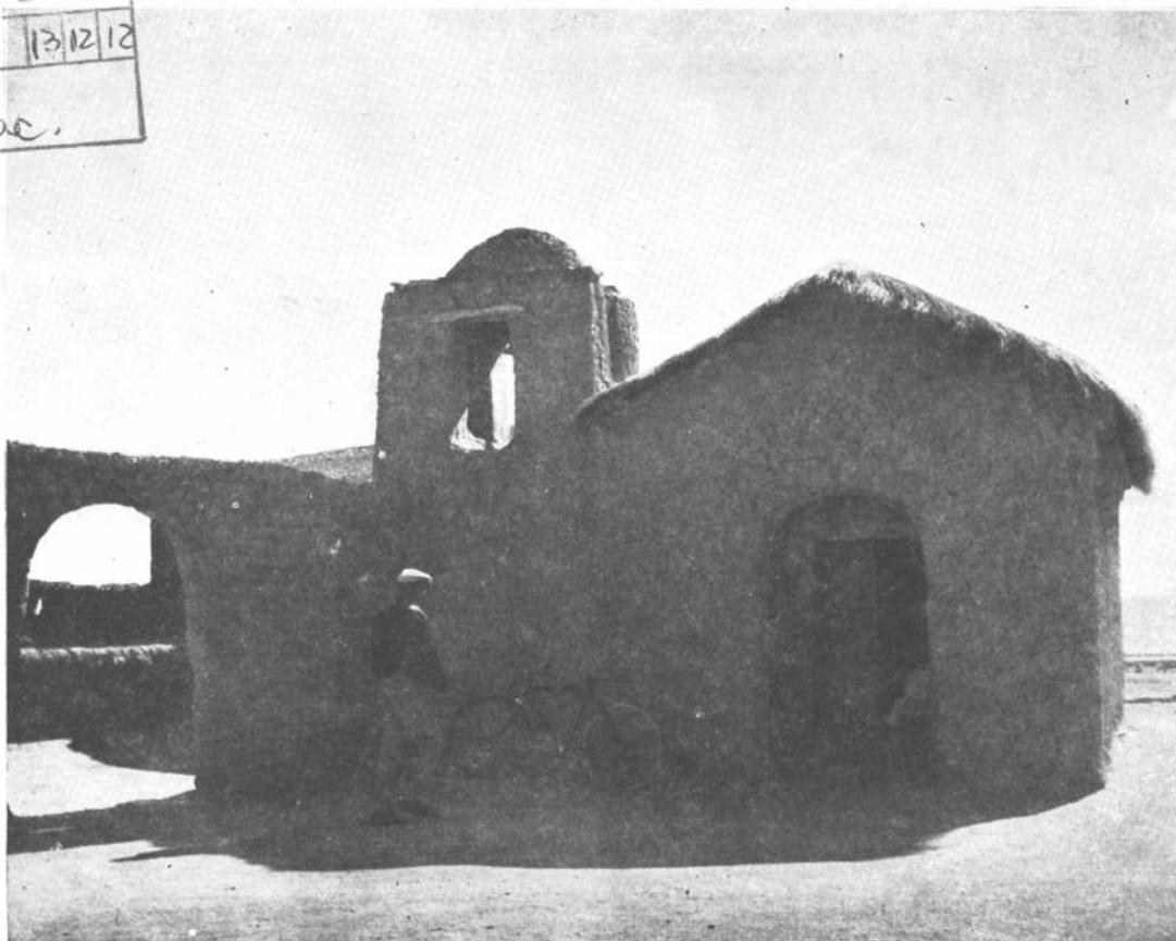
9. Horno de pan, Casabindo. 10. Ventilaciones en los muros piñones de la cocina, Casabindo. 11. Puerta en arco, Casabindo. 12. El conjunto rural de Rodeo. 13. Oratorio del conjunto.
