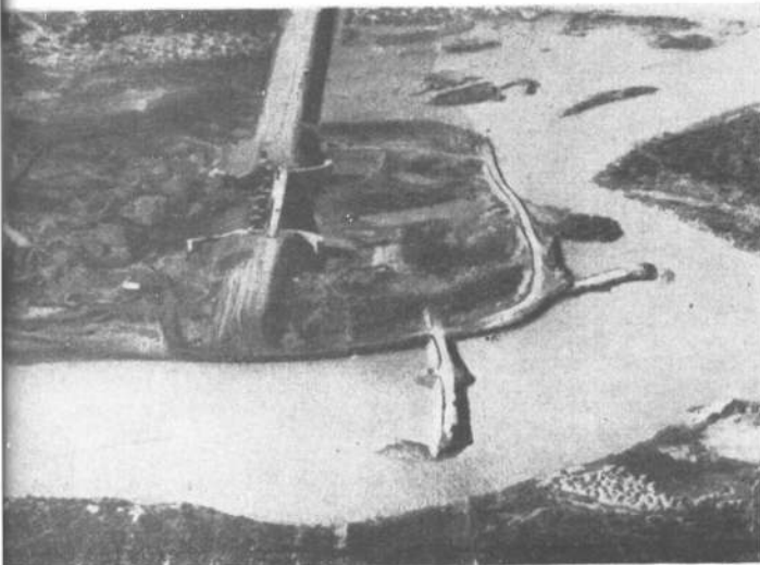
Abajo: las obras en Portezuelo Grande: vista aérea y parcial de las compuertas y vertedero.
