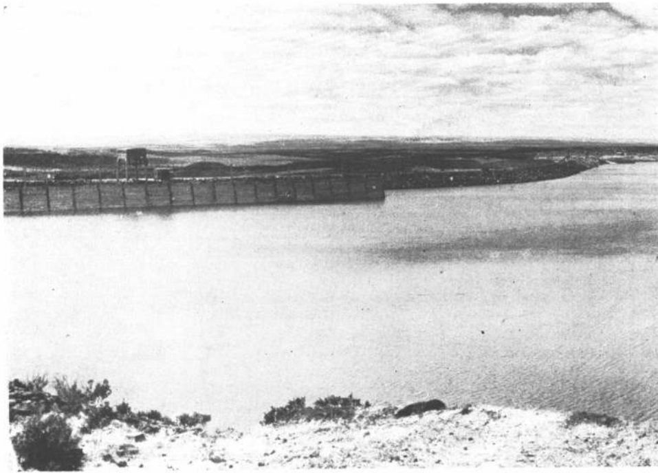
Vista del embalse con la obra de toma (izquierda) y el murallón del dique hacia el fondo (derecha). En las fotos de la página opuesta se aprecian otras vistas aéreas del mismo sector durante la última etapa de construcción. En la foto de la derecha se ve el dique desde aguas abajo y con el vertedero en primer término.
