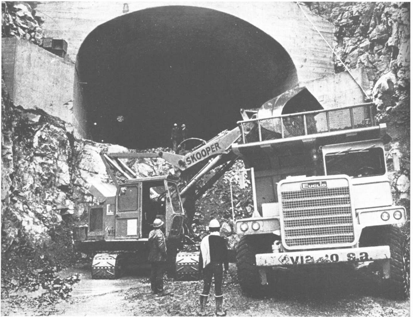
La construcción de los enormes túneles requiere importantes obras de ingeniería, realizándose trabajos de refuerzo no previstos en el proyecto. El equipamiento exigió créditos por 1.200 millones de pesos (Agua y Energía y BND) que se sumaron al equipo de Vialco. La planta dosificadora de hormigones es automática y con memoria electrónica. Los encofrados deslizantes tienen gatos hidráulicos. En la otra página se muestran la planta y corte de la presa (en escala 1:5.000) y del túnel de aducción a la central (en escala 1:1.000). Las fotos presentan un parcial del encofrado y una vista aérea del cierre del cauce con las entradas de los túneles derivadores.
