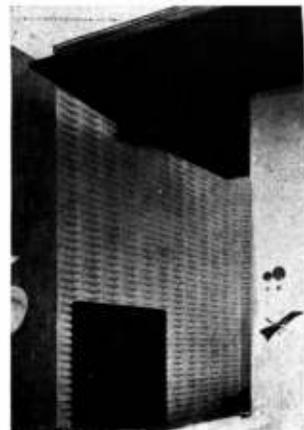
ta paredes de ladrillo con junta tomada. Se pueden colocar grandes superficies con poca mano de obra. Panel aislante liso con un espesor mínimo de 10 milímetros, muy liviano y diseñado para múltiples usos.
