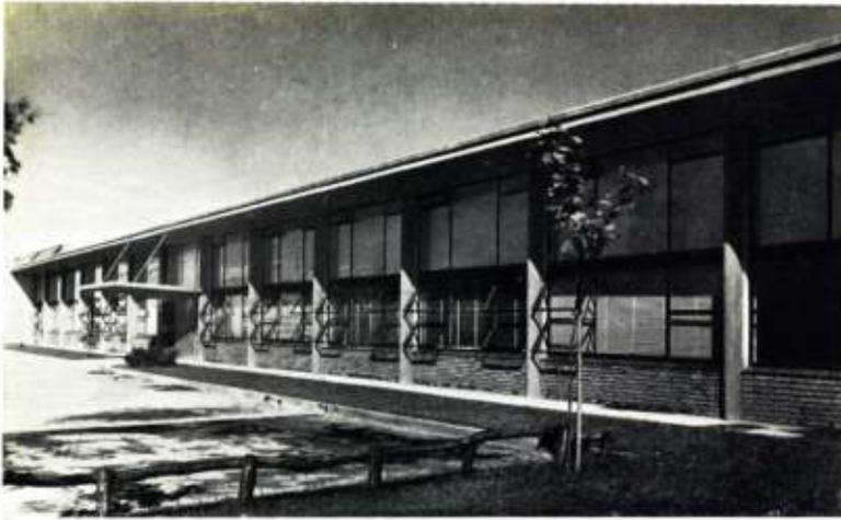
Conjunto de varios edificios separados por jardines; construcciones en hormigón armado, excepto la planta de fabricación, en sheds de hierro sobre vigas armadas y columnas con separación 10 x 20 m.; la parte de servicios generales, en el centro de la planta a ampliarse, es de doble shed de hormigón armado, material usado para poder soportar el calor y los ácidos que emanan varios de las secciones allí ubicadas.
