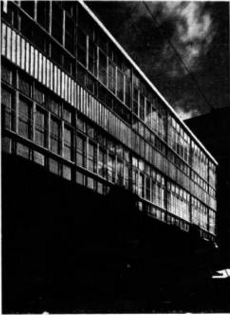
Edificio comercial, de subsuelo, planta baja y dos pisos altos. Elemento primordial: carpintería integral del frente, realizada en madera.
