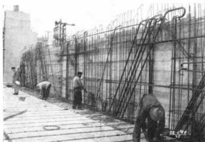
Preparación de la armadura de la parte superior de la viga K, de 25 metros de luz y de 7,30 de alto; su parte inferior tiene aberturas para puertas; está colocada donde debió ir un tabique divisorio interno del sector de oficinas.
