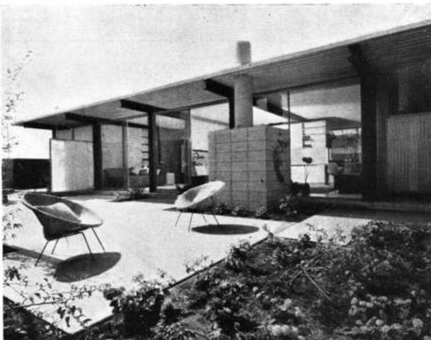
La caja de la chimenea, construida conjuntamente con la losa del piso, está por fuera de la pared de vidrio pero por debajo del alero que forma el techo.
