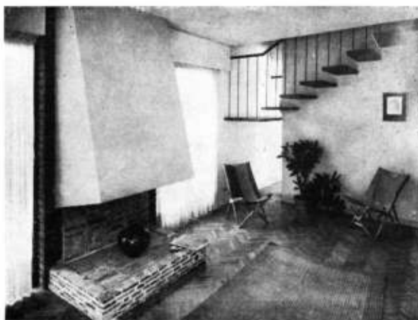
La escalera semi-fija en voladizo.
