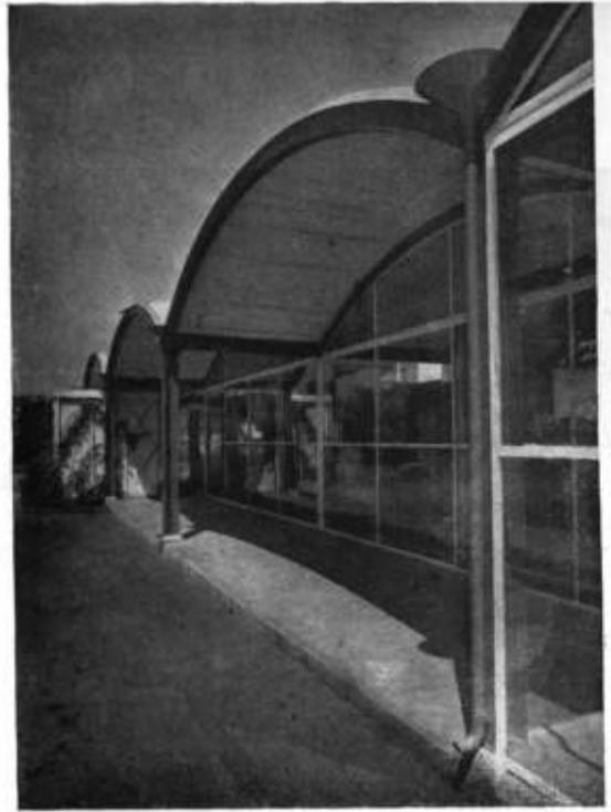
La línea ondulante del techo está acentuada por los cabezales de los desagües colocados en las vigas verticales.
