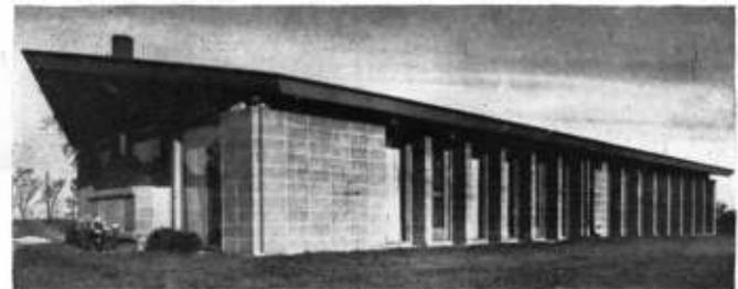
Los bloques de concreto fueron diseñados en módulo de 4 pies. Todos los vidrios de esta fachada este son fijos y el sistema de ventilación se hizo por un sistema de rejillas encima o debajo de los vidrios.
