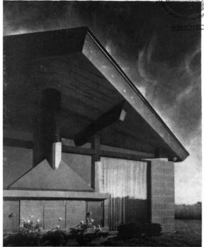
Fachada sur, con la gran saliente del techo y con la parte exterior de la chimenea. Los leños pueden colocarse en los cajones de madera desde afuera y retirarse desde adentro; para eso, hay dos pueritas de madera.
