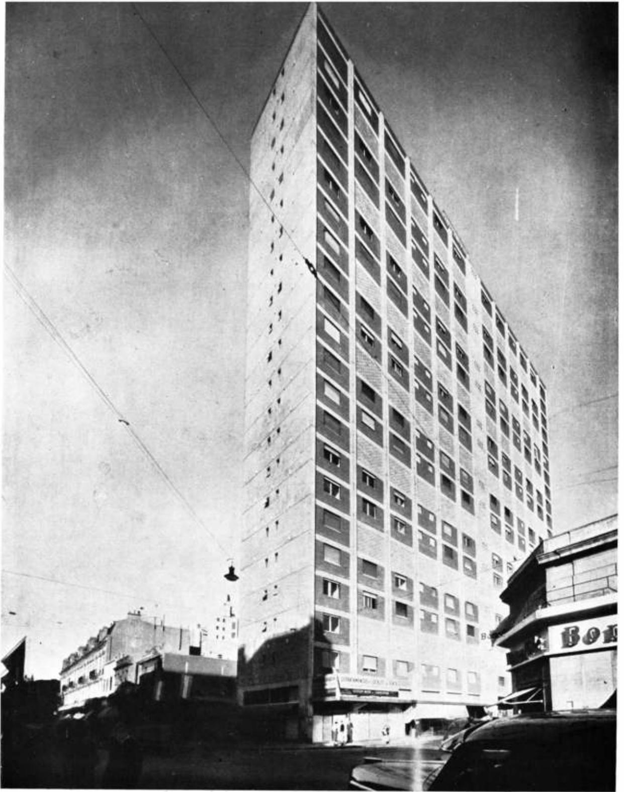
El edificio visto desde la intersección de las calles Charcas y Talcahuano. La estructura modular así como todos los elementos de hormigón armado se dejaron a la vista y fueron martelinados.
