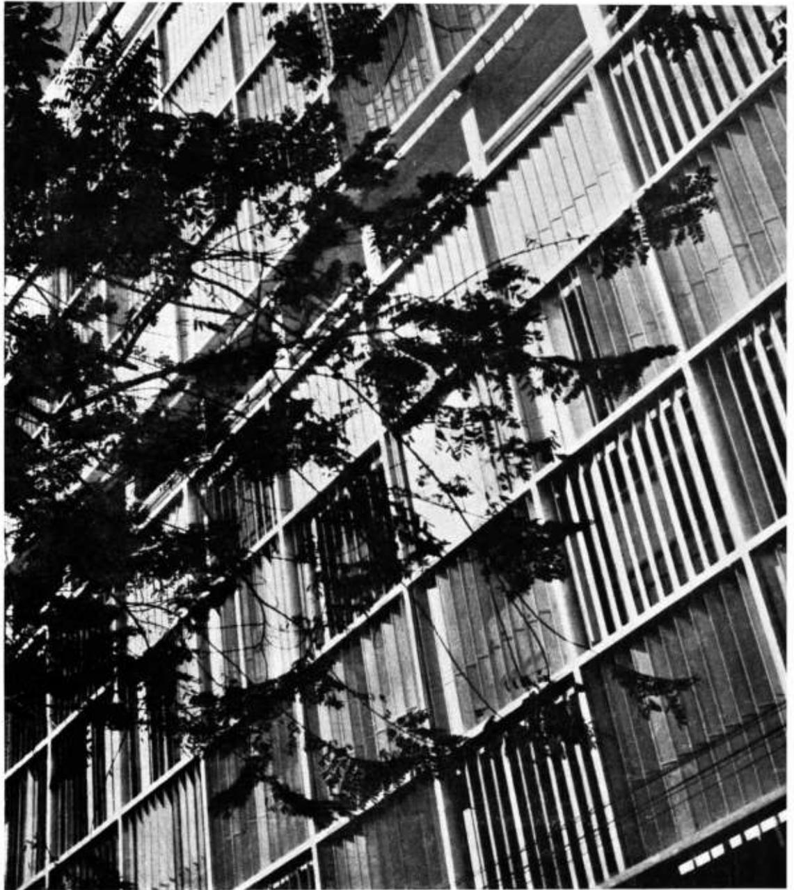
Un detalle de la fachada sobre la avenida Roosevelt, donde puede apreciarse el sistema brise-soleil de vidrios especiales.
