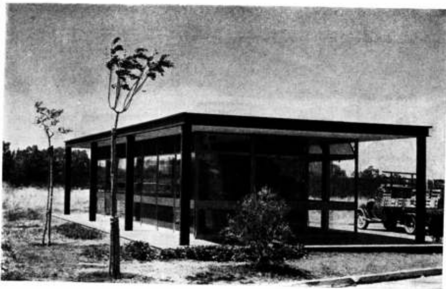
Cabina tipo A.
