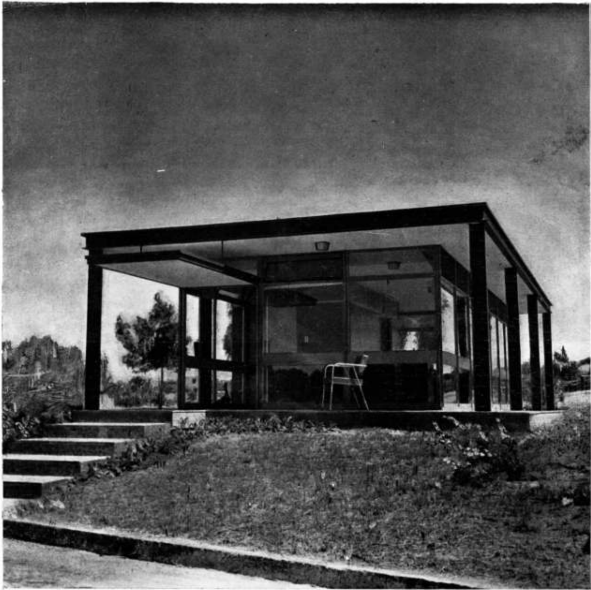
Cabina tipo A.
