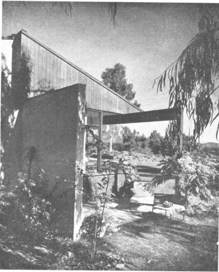
Detalle exterior del ángulo sudeste del dormitorio principal.
