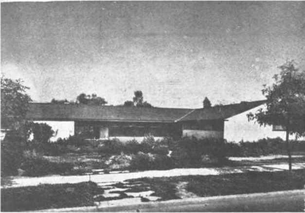
Vereda de entrada. Cuando la cortina del rincón comedor está cerrada permite una hojeada al jardín que está detrás del living room
