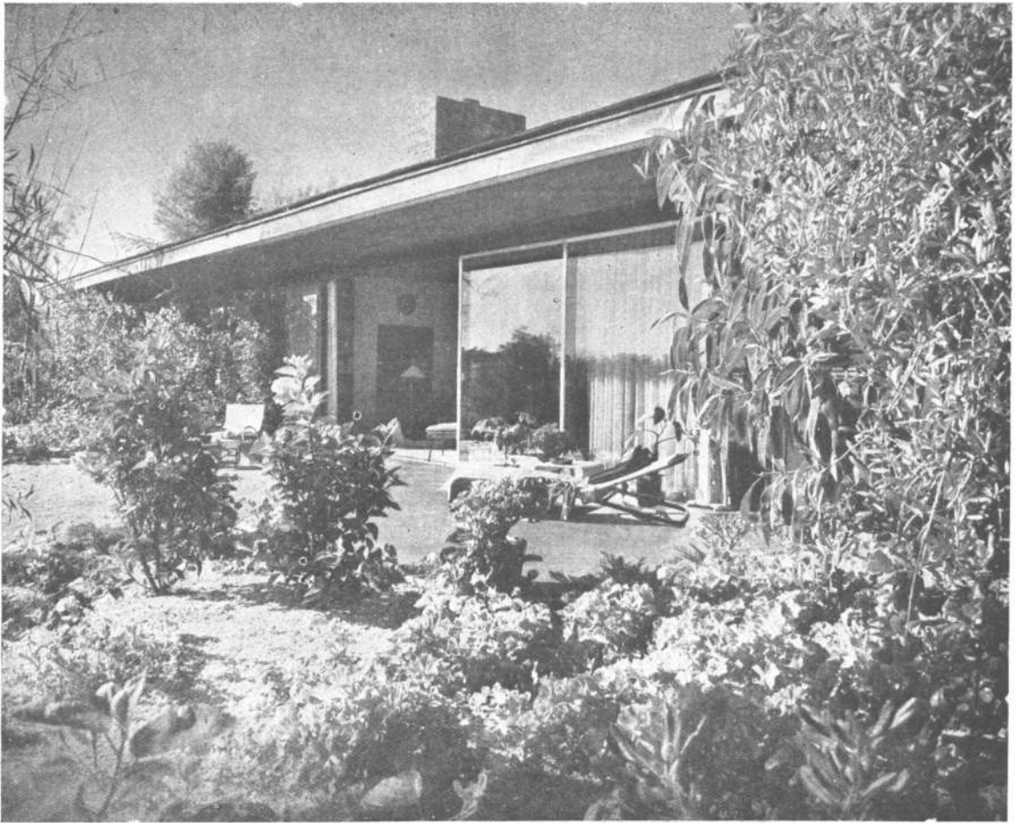
Mirando desde el jardín hacia la chimenea y el ala de dormitorios a la izquierda.
