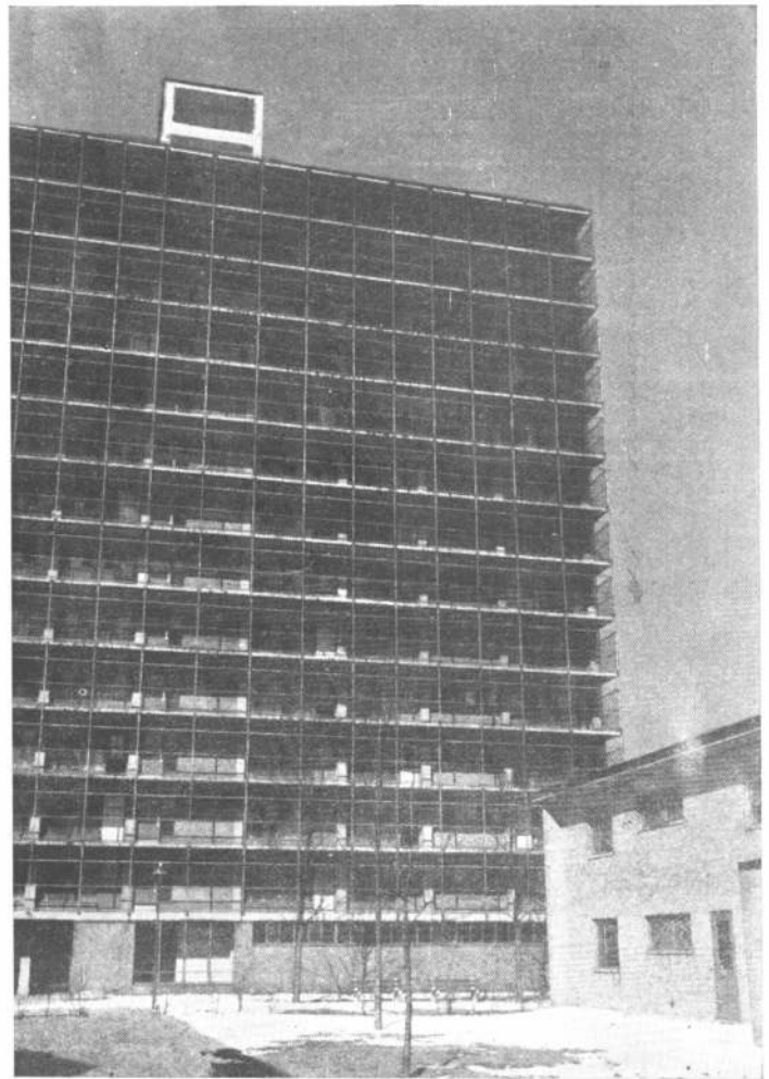
En esta vista parcial puede apreciarse la disposición de los pasillos que vinculan entre sí y con los ascensores a los distintos departamentos. Una de las casas de departamentos de dos plantas puede verse abajo, en construcción.
