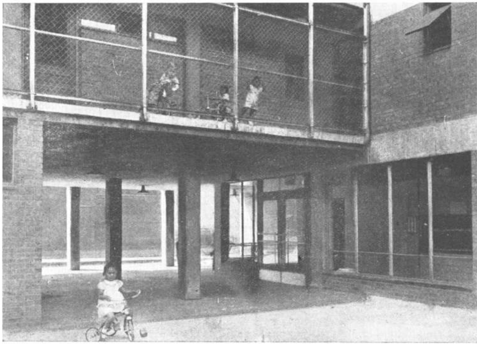
Detalle de la entrada a uno de los edificios de 7 plantas, vista desde el lado norte.
