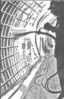
La MALLA ACINDAR —construida con varillas de acero soldado de **alto límite de fluencia**— cuenta con la garantía de las más severas normas de calidad. La MALLA ACINDAR se fabrica con modernos procedimientos automáticos y su uniformidad y calidad es controlada en nuestros laboratorios de ensayo de materiales de la planta de Villa Constitución. La MALLA ACINDAR reemplaza a los entramados de acero con ataduras de alambres en:
