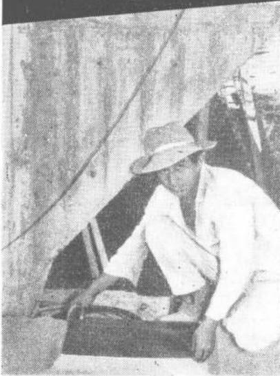
Apoyo de larga duración mientras está siendo instalado en un puente de Méjico. La viga principal del puente se monta sobre el apoyo.
