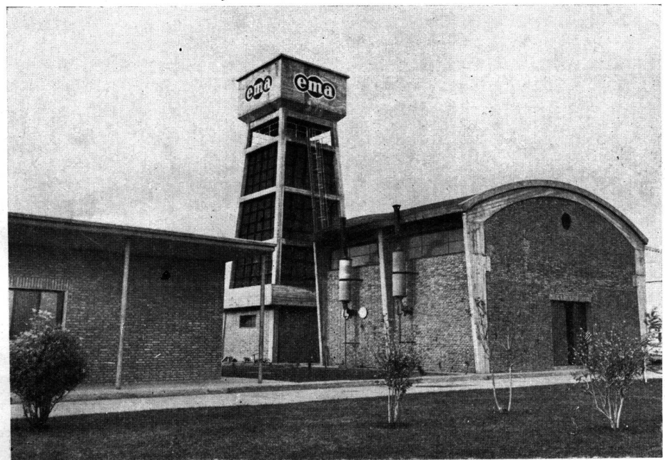
Detalle torre-tanque y refrigeración.
