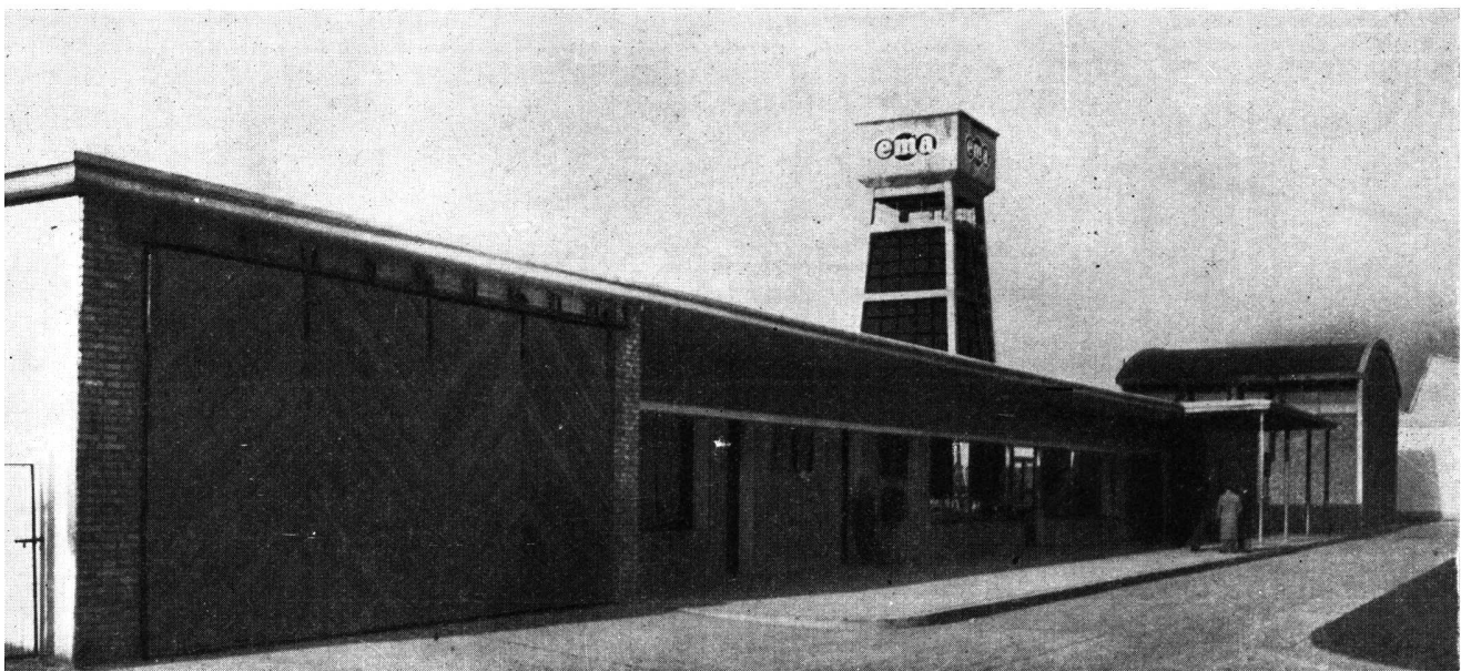
Pabellón vestuario, usina y torre-tanque, y torre de refrigeración.
