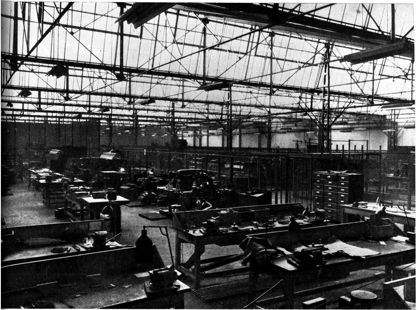
INTERIOR DEL PABELLON FABRICA — Luces de columnas 10 × 10 metros. Divisiones de carpintería metálica y alambre móviles.
