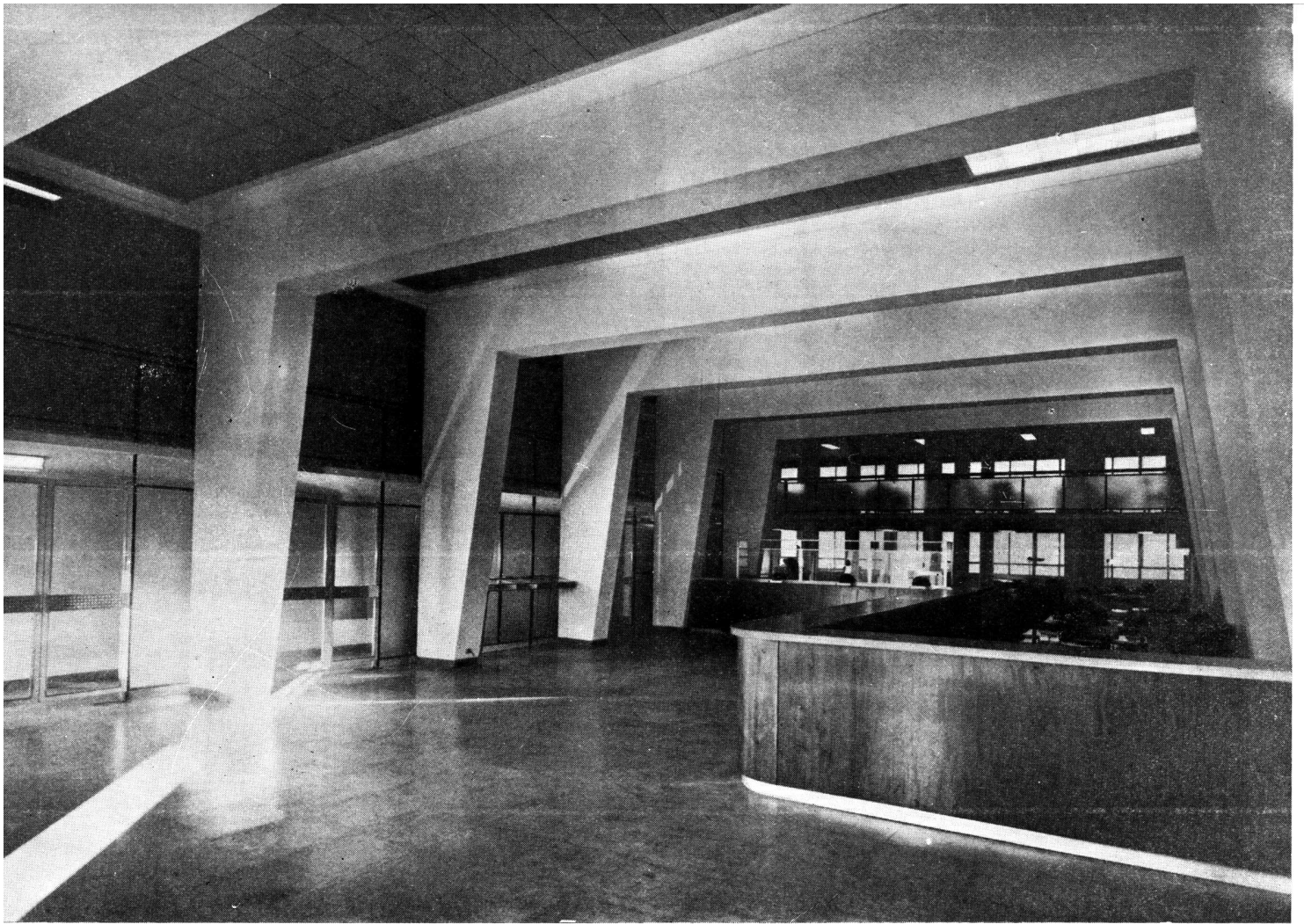
El hall público. Mostrador y cajas de atención al público. Lateral y atrás, entrepiso. Mampara de separación en planta baja, de la circulación de público y empleados: carpintería de hierro con vidrio armado.
