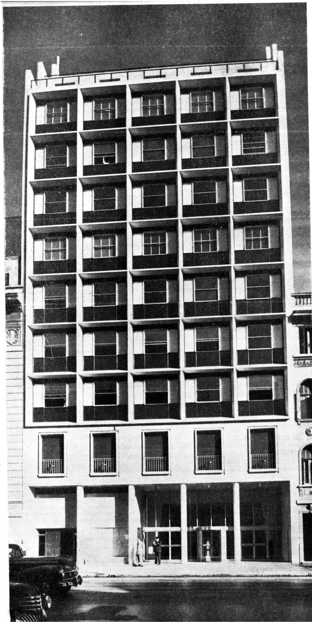
Fachada. Pórtico y vidriera del hall público de la Sociedad. Primer piso, revestido con mármol gris punilla, destaca la parte noble del edificio. El frente destaca el criterio constructivo y el elemento de cerramiento (metálico) de columna a columna y de losa a losa.
