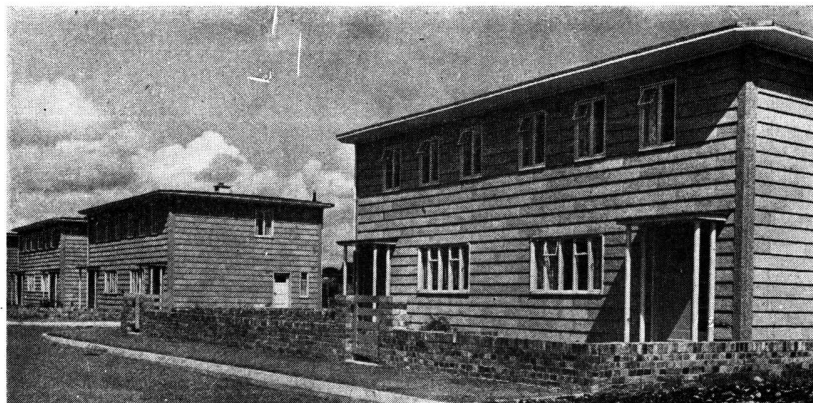
Estas casas "Airey" fueron diseñadas especialmente para las ciudades y pueblos del interior de Gran Bretaña. Tienen columnas de concreto y concreto prevaciado.
