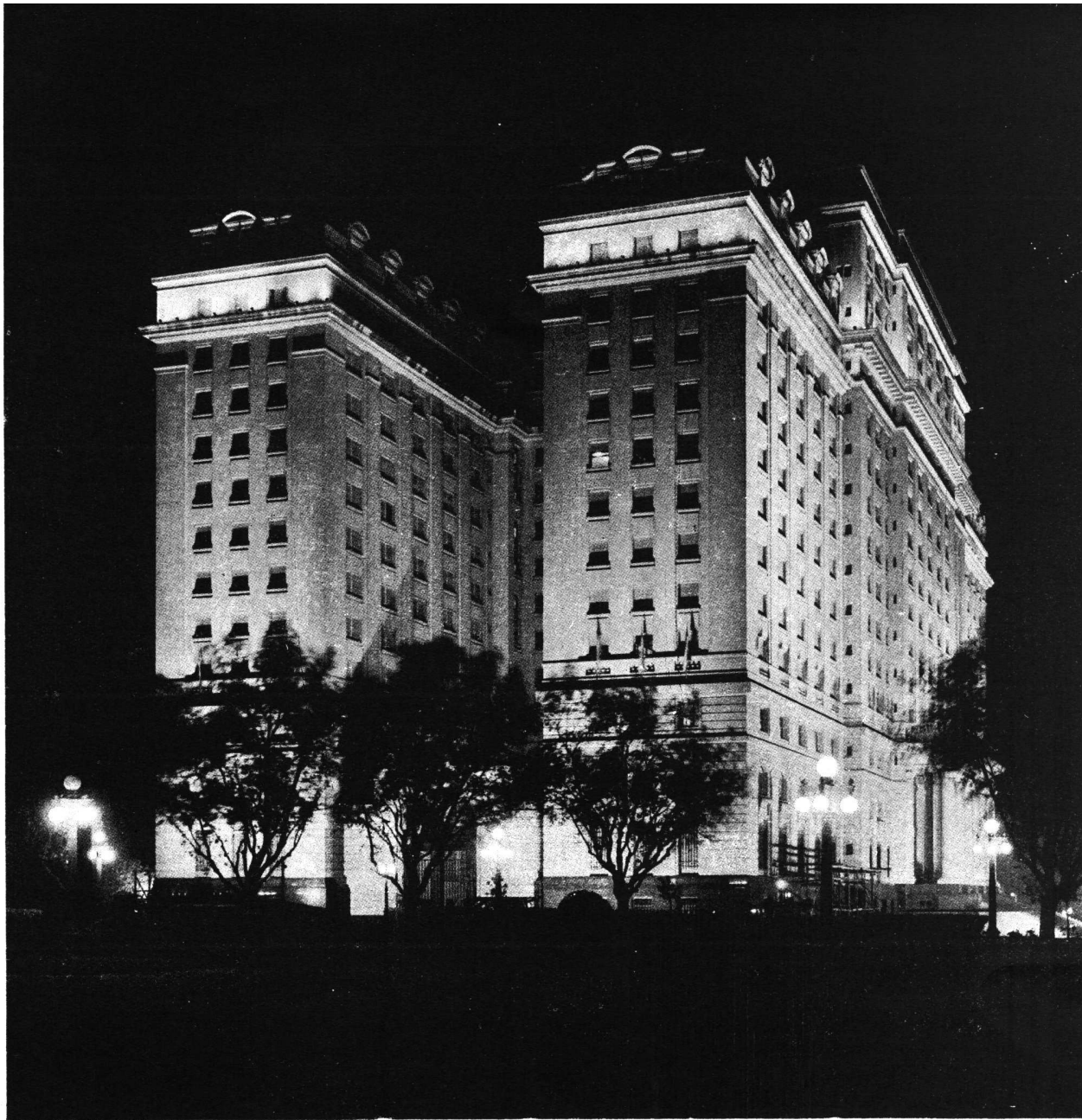
Vista nocturna de la fachada lateral que da a la Avenida La Rábida
