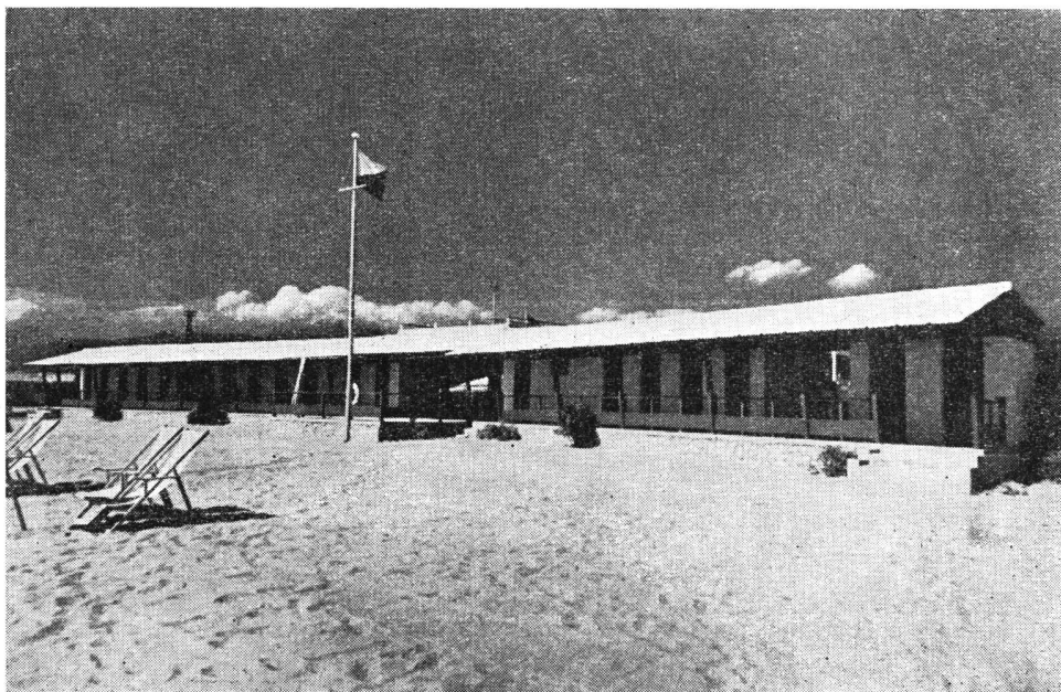
Pabellón de vestuarios sobre la playa
