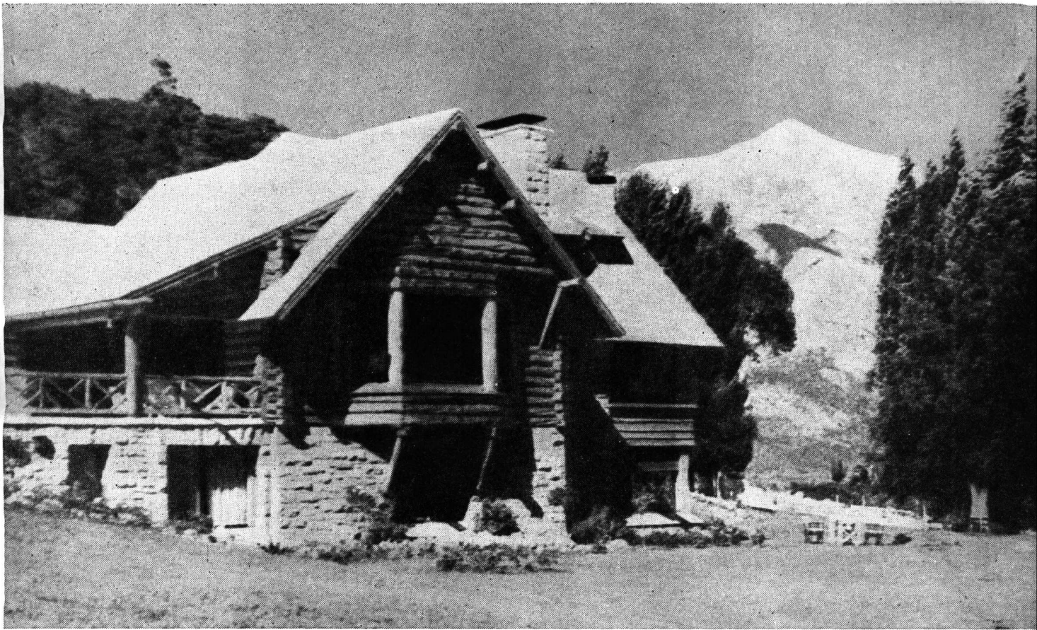
Sector de fachada del living-room y el comedor.
