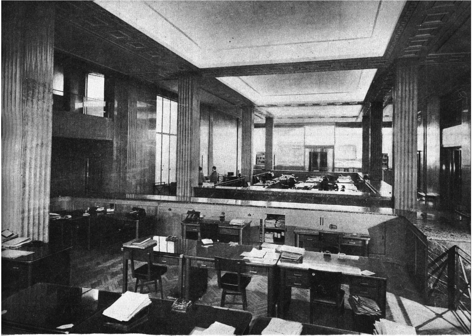
Vista general de las oficinas de planta baja.
