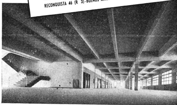
Vista de un interior del establecimiento, que permite apreciar la amplitud del espacio y la profusa luz natural, lograda mediante la adopción y empleo racional del hormigón de cemento portland en la estructura del edificio.
