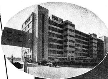
Ventanales de hormigón armado "Verlit" fijos y con balancines del mismo material, accionados con molinillos de bronce. Los ventanales cubren una superficie de 5.100 m<sup>2</sup>. Construidos y colocados por la firma F. Arntsen, empleando exclusivamente cemento "INCOR"
