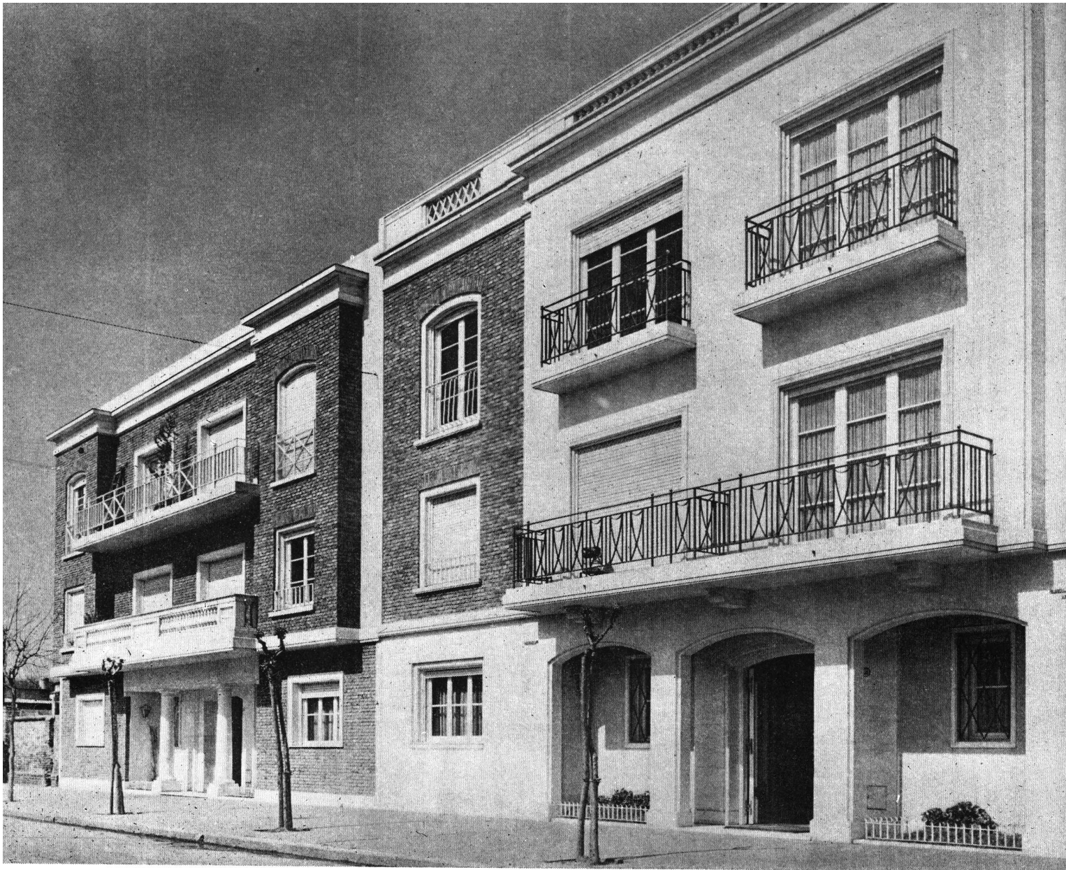
Vistas de conjunto.
