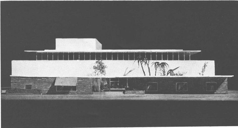
Las paredes del primer piso serán de piedra roja, con matices amarillos y rosados; los pisos superiores con muros revocados y vidrios. Las guarniciones de metales serán de níquel plateado. Los pisos inferiores de baldosas color rosa ante. Todo el negocio es una "inmensa vitrina de exposición". Sin embargo se exhibirán mercaderías del segundo piso en vidrieras suplementarias ubicadas en este costado (oeste).
