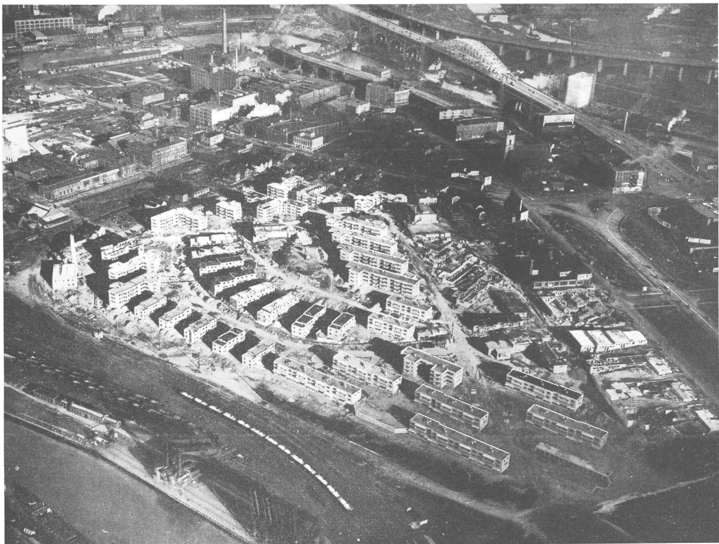
Lakeview Terrace, Cleveland, construido por la Public Works Administration en 1935, y típico de muchas construcciones de viviendas populares realizadas ulteriormente sobre zonas donde se demolieron casas inservibles por las autoridades locales, al amparo de la ley de 1937 llamada U. S. Housing Act, o Ley de Alojamiento de los Estados Unidos. (Arq. J. L. Weinberg).
