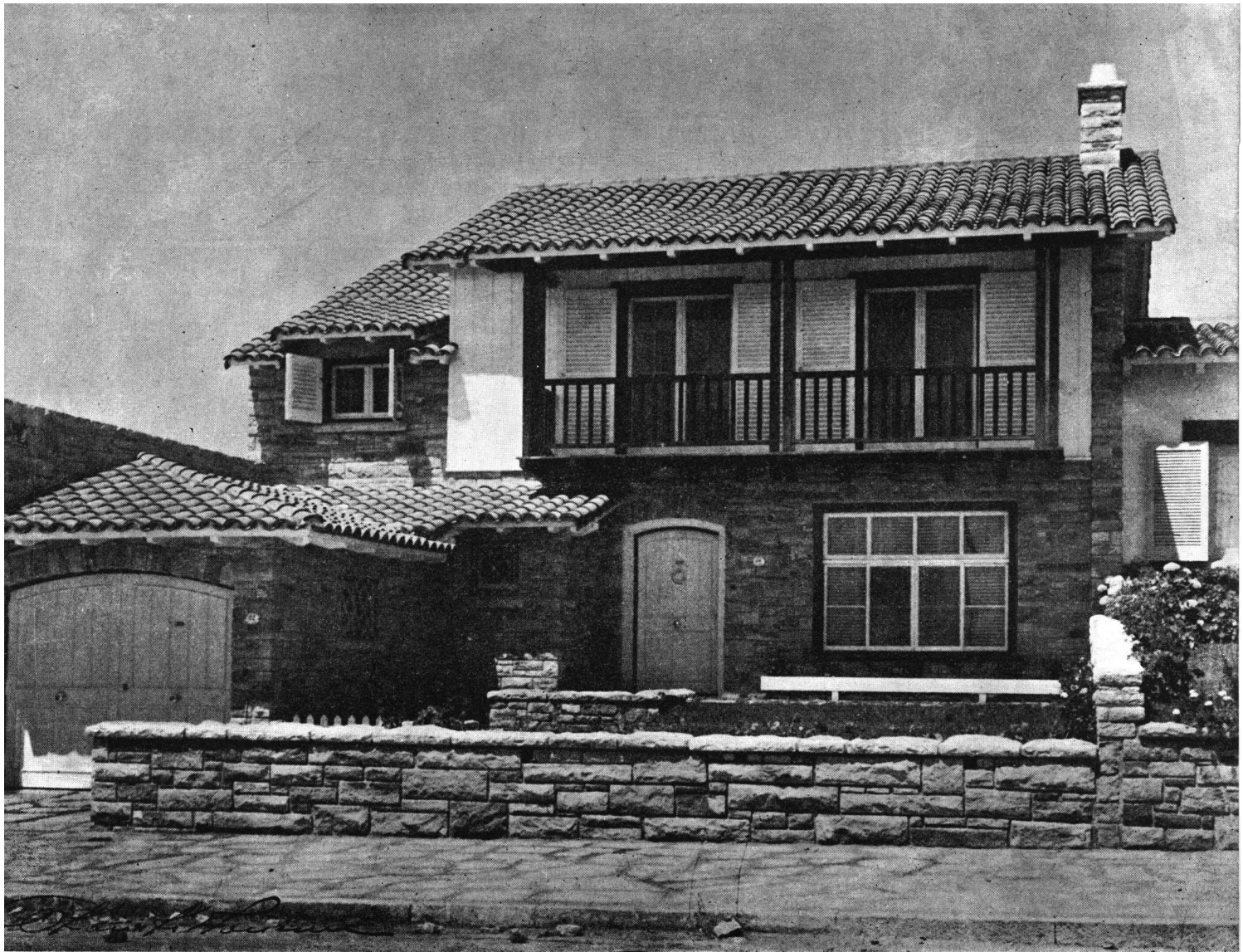
El frente: piedra y revestimiento de madera, tablas anchas con tapajuntas, en madera natural.
