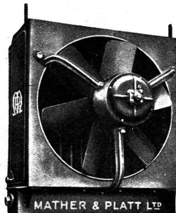
Unidad radiadora "Thermolier" vista de atrás. - El ventilador que impulsa en Invierno el aire caliente, sirve en Verano para refrescar el ambiente.
