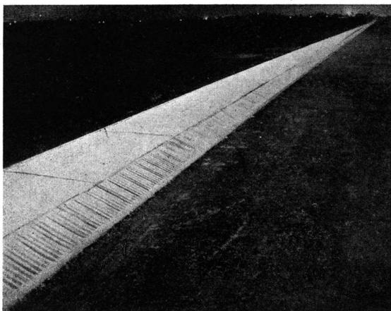
El borde dentado de las marcas de tráfico construidas con Cemento Blanco ATLAS al costado de los caminos, refleja la luz de los faros de los vehículos y aumenta la visibilidad, especialmente en las noches lluviosas, disminuyendo así la posibilidad de accidentes.
