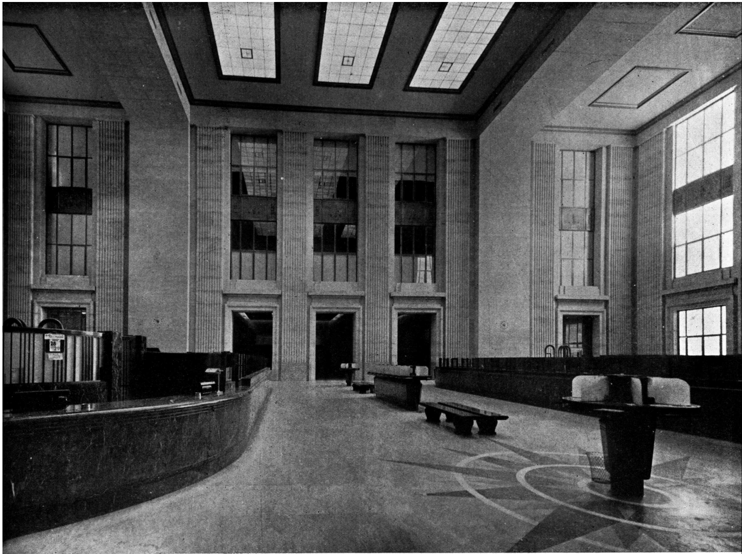
VISTA DEL GRAN HALL DE OPERACIONES EN LA PLANTA BAJA
