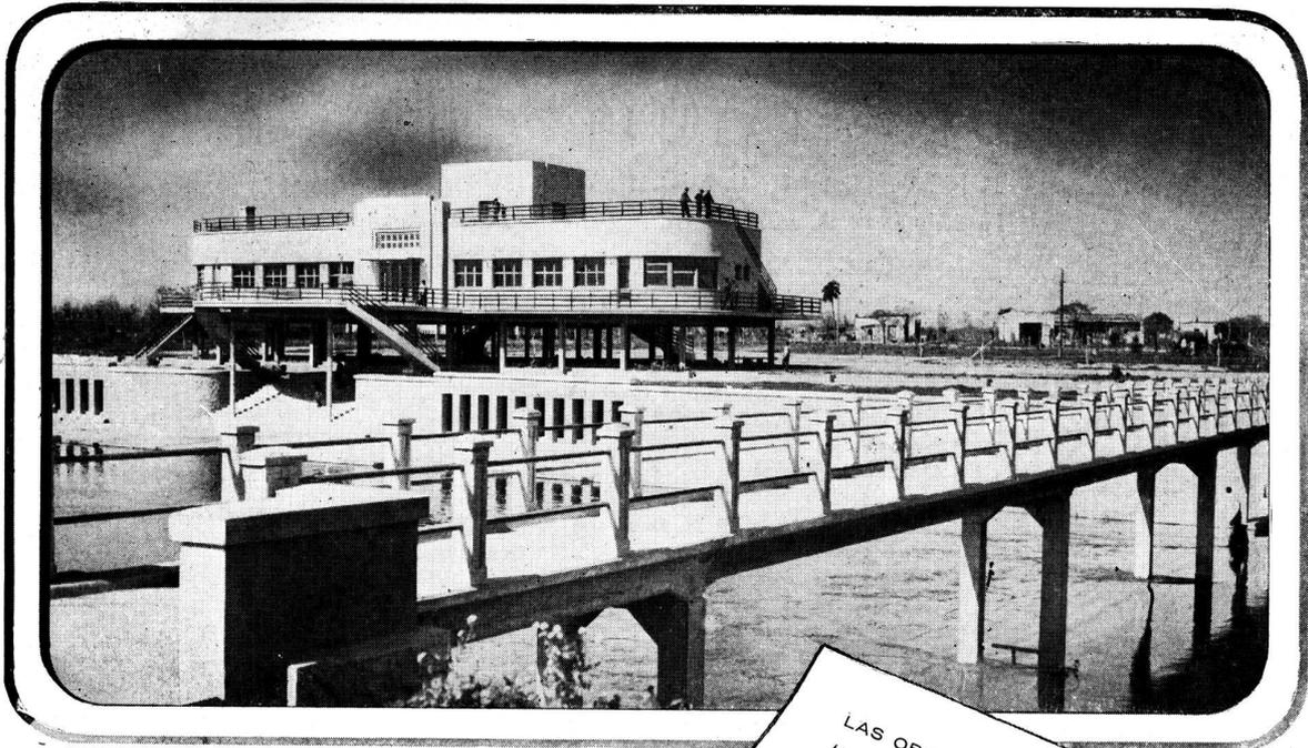
Edificio del Bañeario de Marcelino Ugarte (Salto).—Al frente la pasarela de hormigón construida sobre columnas del mismo material, cuyo largo es de 60 metros, ancho 3 mts. y alto, desde el nivel normal de las aguas, 4 mts
