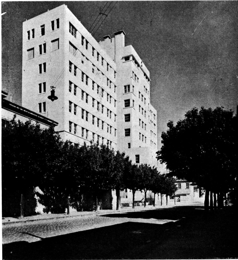
INSTITUTO DE PERFECCIONAMIENTO MEDICO - QUIRURGICO (HOSPITAL DURAND) Calles Juan B. Ambrosetti esq. Canalejas Obra de la Dirección General de Arquitectura del Ministerio de Obras Públicas de la Nación
