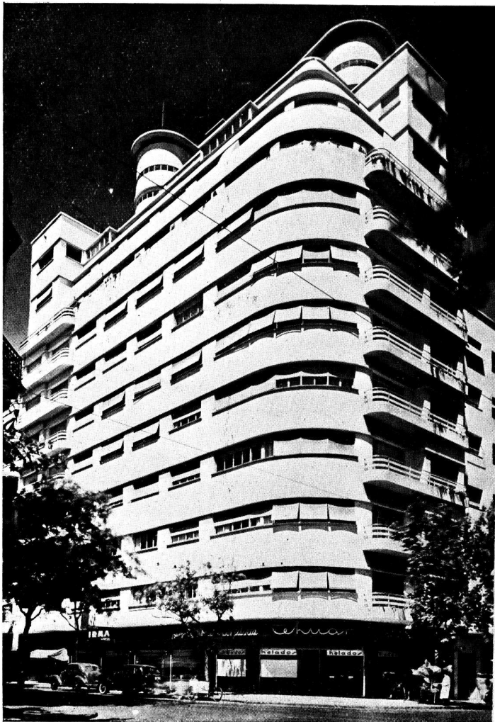
FACHADA SOBRE SANTA FE Y JUNIN
