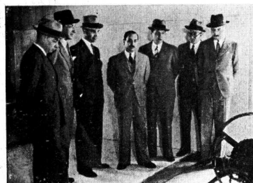
Concurrentes a la visita del puente
