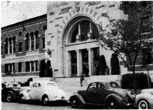
Edificio de Educación Física.
