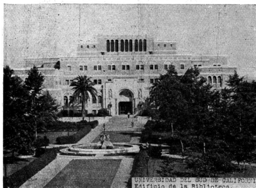
Edificio de la Biblioteca.
