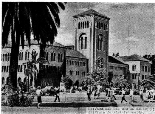
Edificio de Administración.
