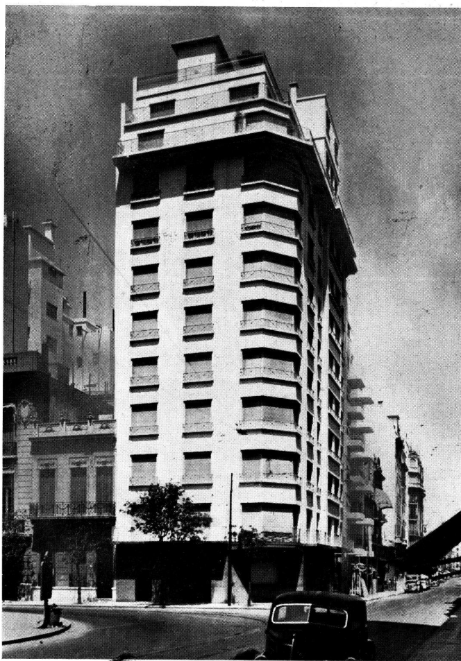
Edificio de Renta —Calle Arenales esquina Montevideo
