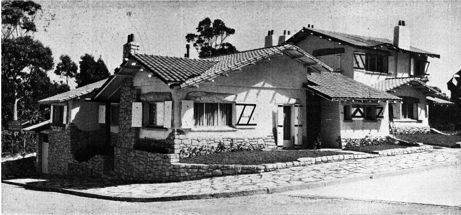
FACHADAS SOBRE LAS CALLES ALMIRANTE BROWN Y VIAMONTE
