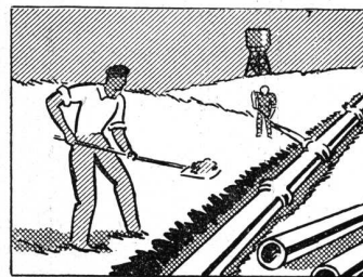
CAÑOS DE CANALIZACION: Resistentes a las presiones hidráulicas elevadas y a la acción del suelo. Su largo y su sistema de juntas simples, constituyen una fuente de economía.
