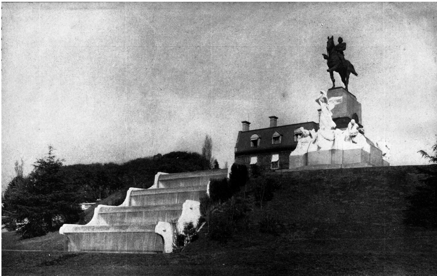
Vista donde se destaca el agregado ajeno al monumento y los criterios opuestos en concepción de formas y construcción
