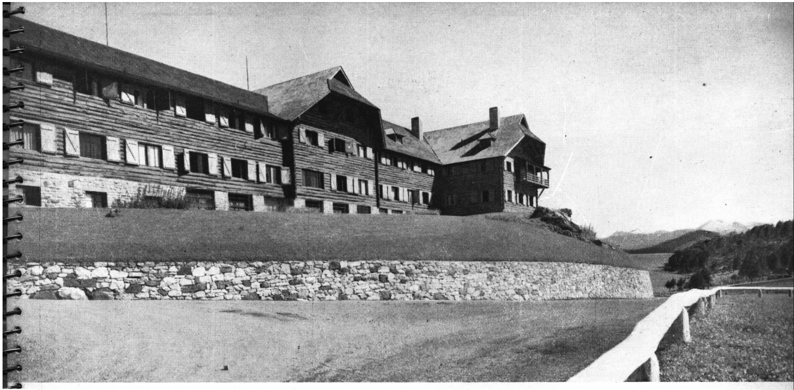
VISTA EXTERIOR DESDE LA RAMPA DE ACCESO
