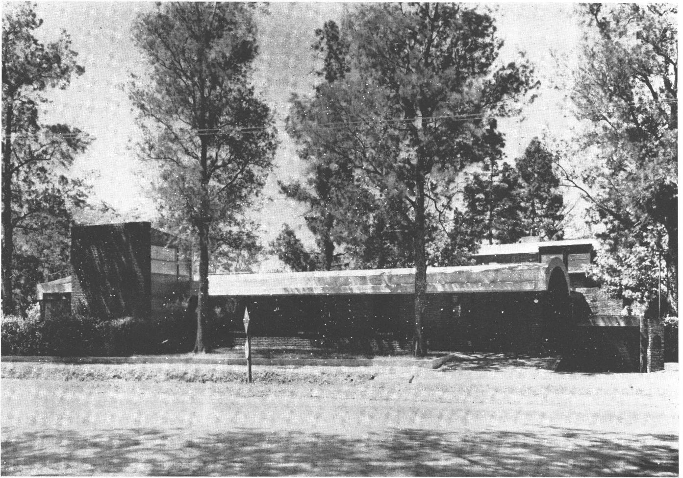
CASA D — FACHADA POSTERIOR
