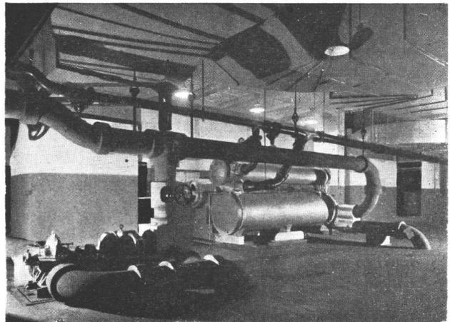
Fig. 11. — Sala de máquinas; sección compresores de aire acondicionado.
