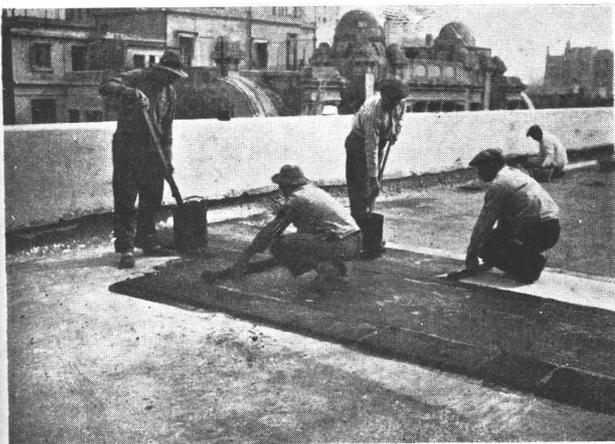
Fig. 5. — Un detalle de colocación del techado.
