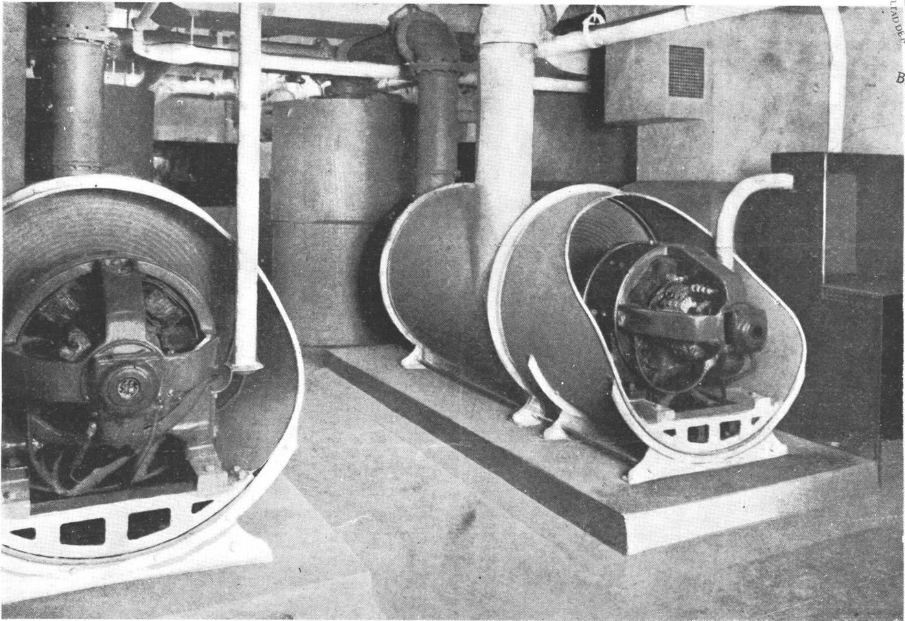
Fig. 18. — Instalación de dos turbinas productoras de vacío.
