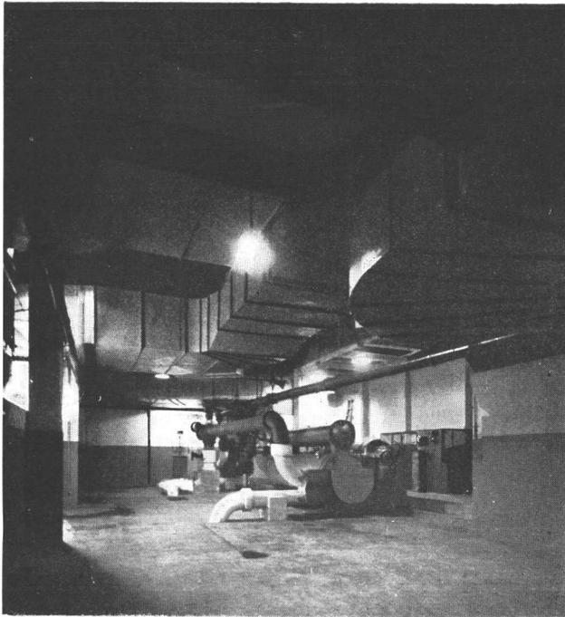
Fig. 13. — Sala de máquinas. Compresor de aire acondicionado y, al fondo, filtros de aire.
