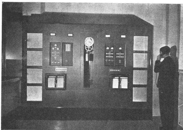
Fig. 8. — El tablero de control de la instalación de baja tensión; reloj patrón y alarmas.
