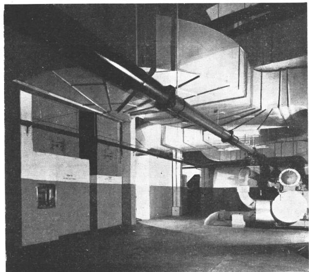
Fig. 12. — Sección de aire acondicionado de la sala de máquinas.
