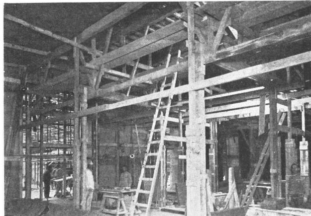
Fig. 3. — Detalle del trabajo de hormigonado.
